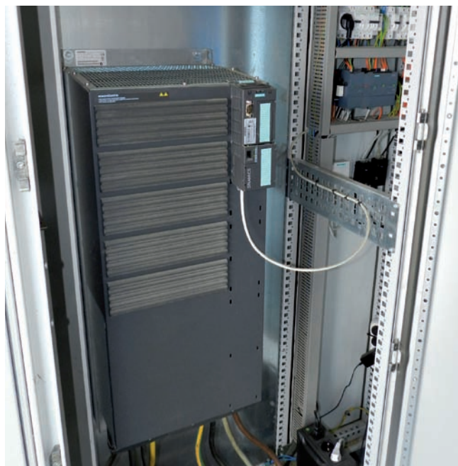
Otáčky elektromotora čerpadla riadi moderný frekvenčný menič Sinamics G120 spoločnosti Siemens.
